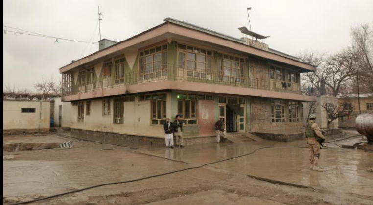
HLAVNÍ BUDOVA PROVINČNÍHO SIROČINCE V MĚSTĚ ČARYKAR DŘÍVE
